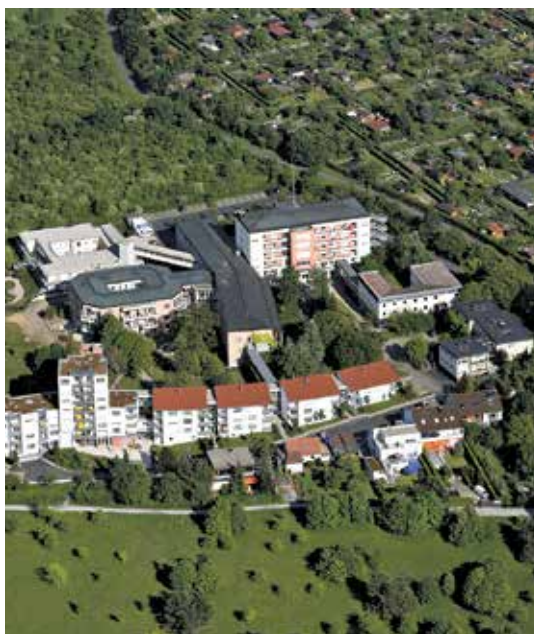
Vielfältiger Komplex: Die Luftbildaufnahme zeigt die Größe der Seniorenwohnanlage am Hubland.
